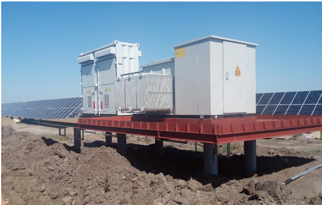
图 5-1 箱逆变一体机基础设计示意图
