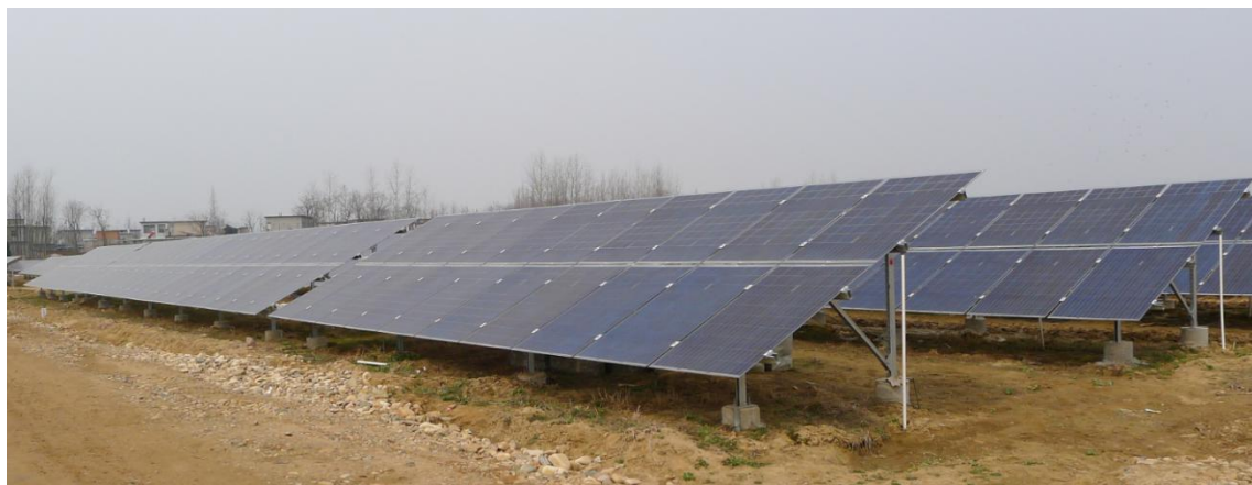
图 5-3 固定式光伏支架图
