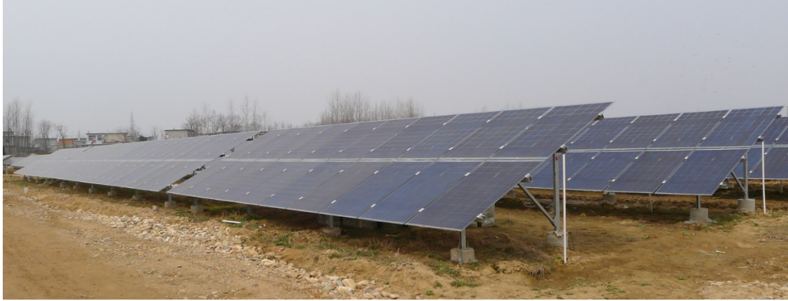
图 5-2 固定式光伏支架图
