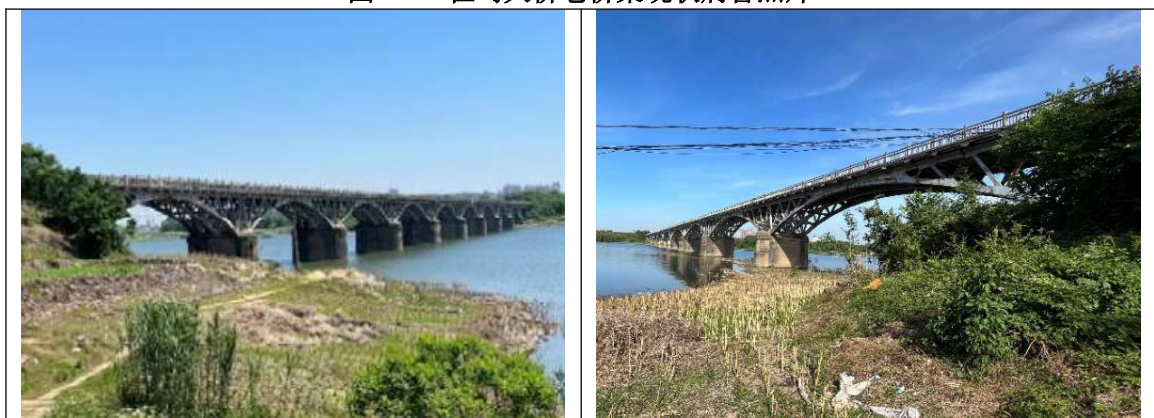
图 2-3 杜坞大桥老桥现状照片
