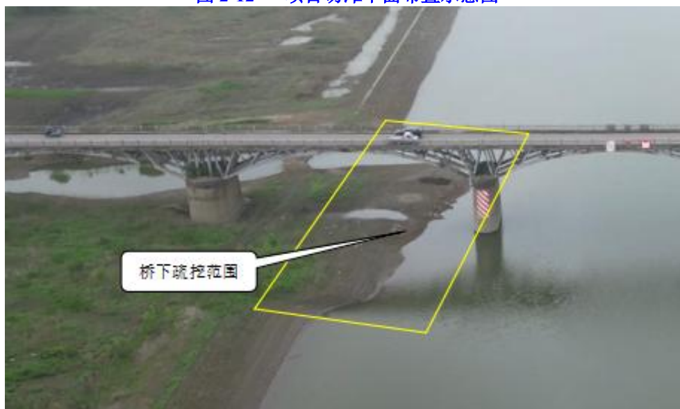
图 2-13 项目切滩断面（红框部分）示意图
