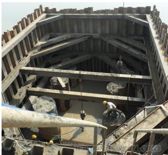
图 2-27 水中承台钢板桩围堰施工
